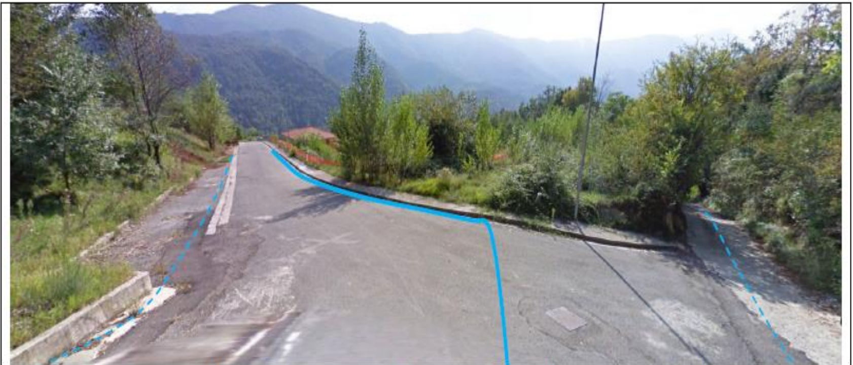
Figura 13 In corrispondenza dell'incrocio via Sopranico / Via sonvico le acque di piena torrentizia si dipanano in 3 diverse direzioni di cui si evidenziano con linee in azzurro quelle potenziali (in tratteggio) e quella preferenziale (continua).
